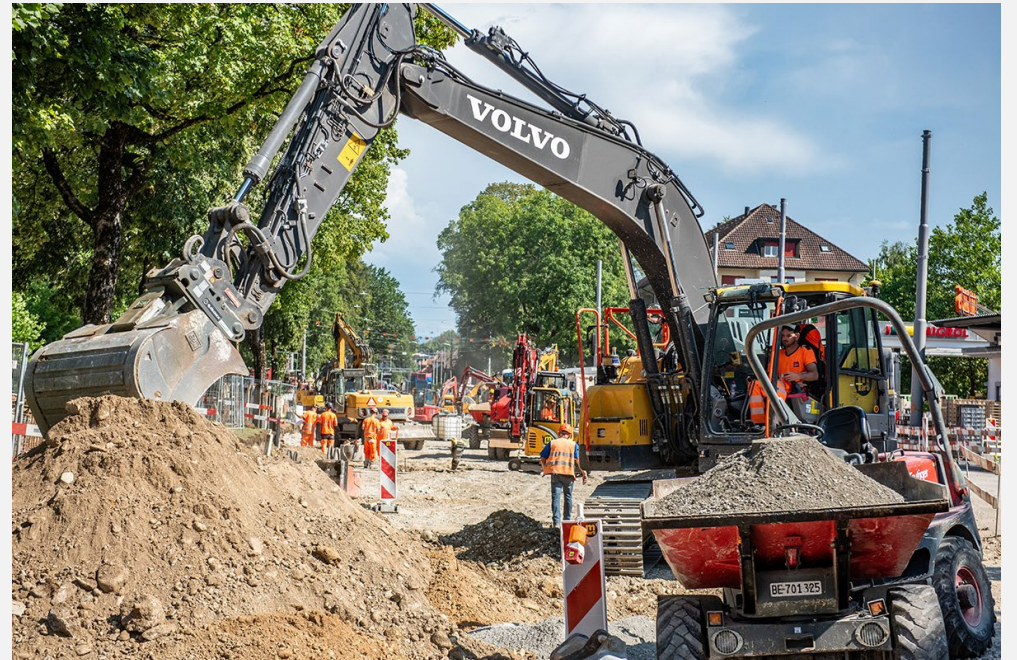
Korrektion Thunstrasse Muri (Foto:Alexander Egger)
