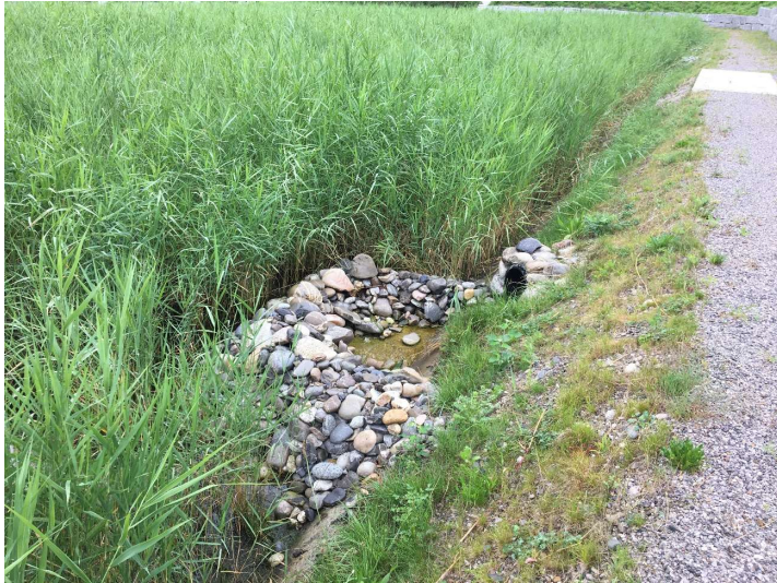
Abbildung 8. Bsp. für bewachsenen Sandfilter (ca. 2 Jahre nach IBN)
