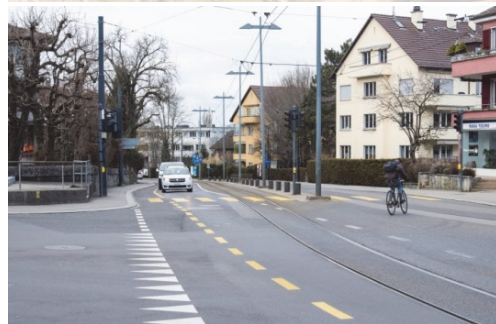
Knoten Dorf-/ Seftigenstrasse, Richtung Bern
