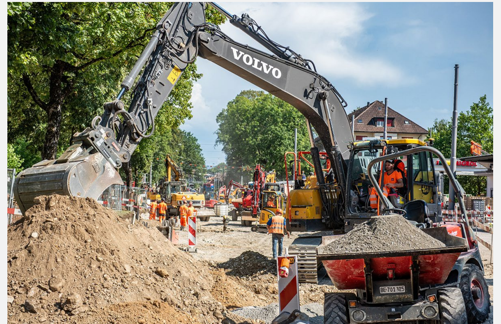
Korrektion Thunstrasse Muri (Foto:Alexander Egger)
